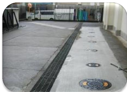
校内に設置されたマンホール
