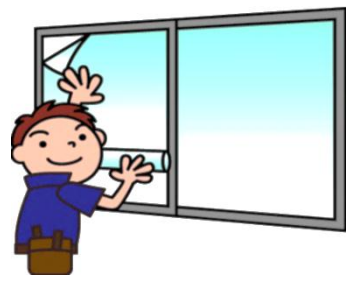
窓ガラスの飛散防止
