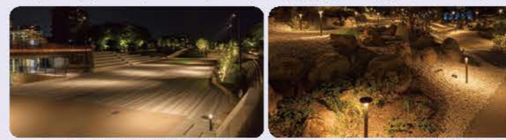
広い範囲を照らす高ポール照明 足元を照らす低ポール照明
