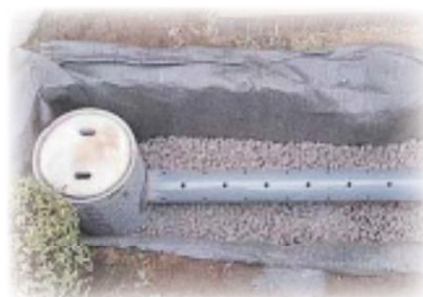
雨水浸透管・浸透ます
