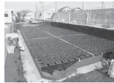
雨水貯留槽は、大きなプラスチック製のプールが地下に埋まっているイメージです
