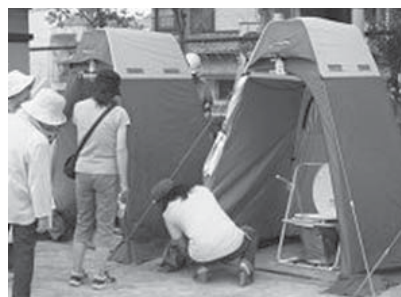
災害時はマンホールの上にトイレブースを設置します
