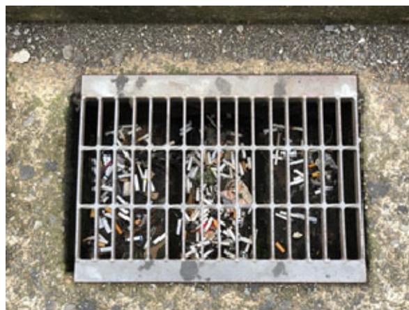
世田谷区内の側溝
