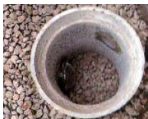
雨水浸透ます
