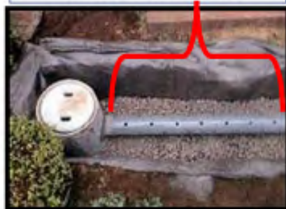
雨水浸透トレンチ
