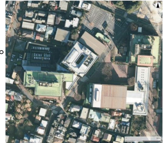
【現庁舎 空中写真】
