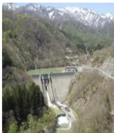
水芭蕉発電所 (長野市)
