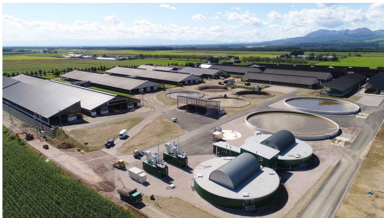
バイオガスプラント
