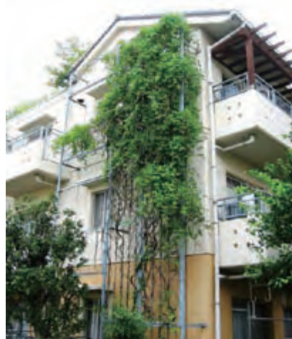
●補助資材を使用した壁面の緑化
