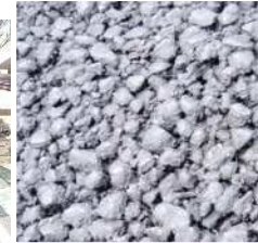
透水性舗装の表面
