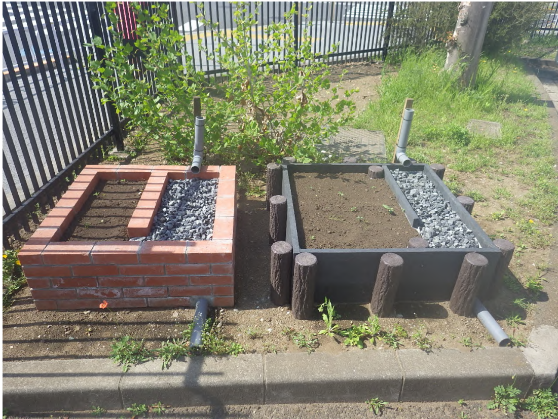
図 4.50 雨花壇の施工例(雨どいはモデル)
