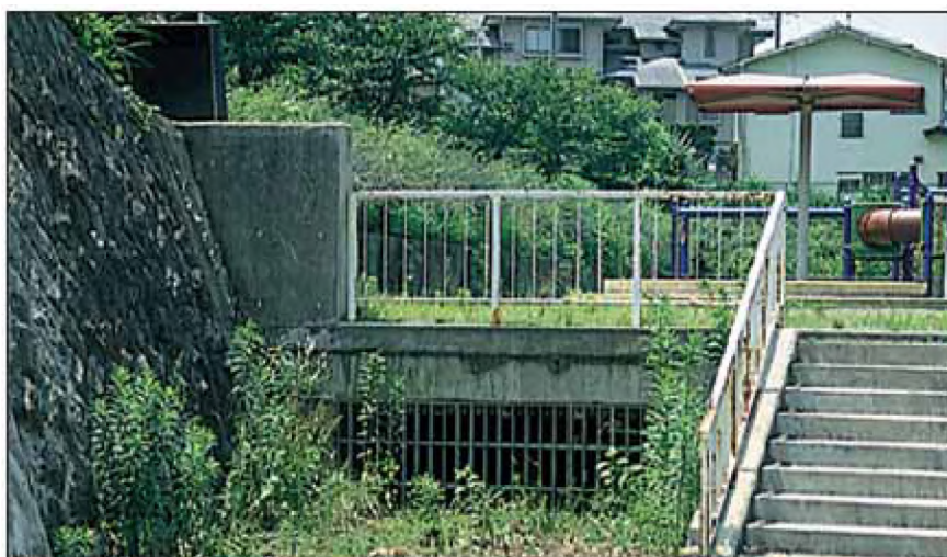
地下貯留槽が一杯になると中央の流出口から地上の公園部に貯留される
