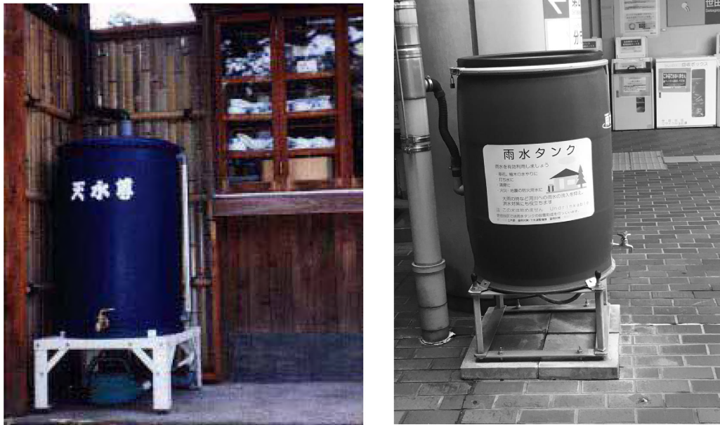
図 4.14 雨水タンクによる雨水貯留(各戸貯留対策)
