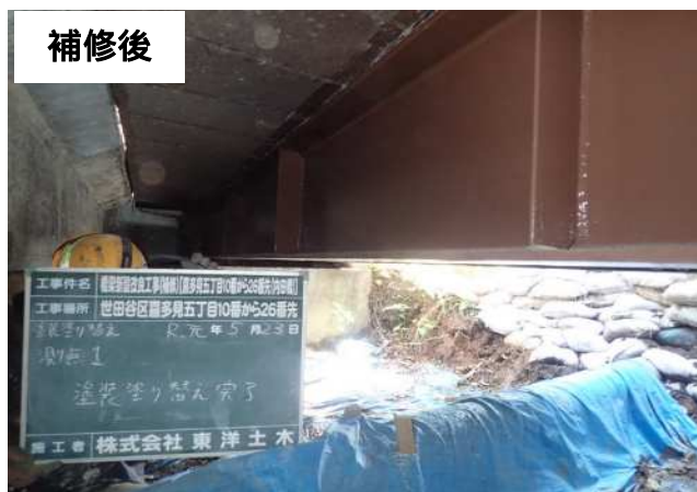
鋼桁塗替え
