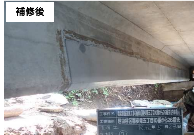
断面修復 (鉄筋が露出した箇所を補修)
