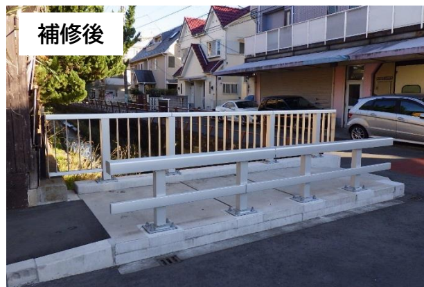
防護柵の取替
