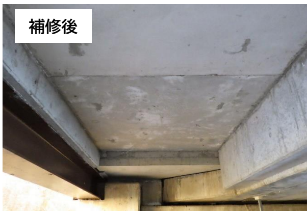
歩道鋼床版の取替え
