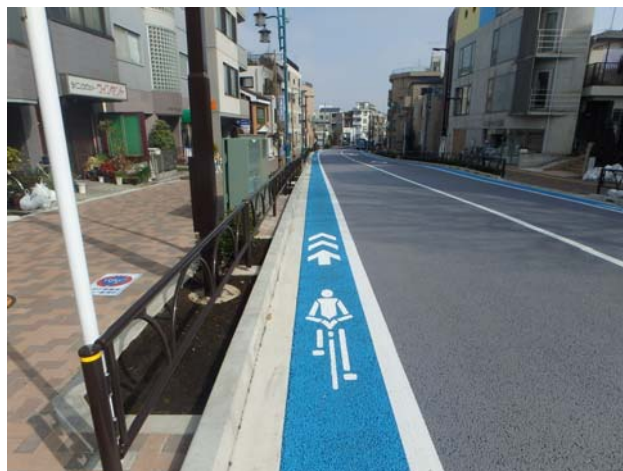
図4-4 自転車走行帯の整備事例(補助154号線・世田谷三丁目)
