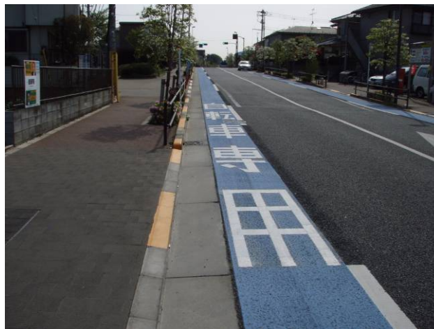
図 4-1 自転車専用通行帯の整備事例(補助 54 号線・桜上水三丁目)
