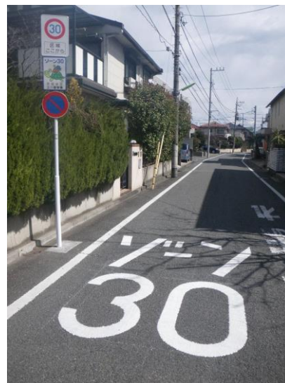
ゾーン30の路面標示と道路標識
