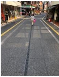
道路構造を見直し、店舗出入口の段差を解消した例
