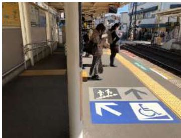
床面の車椅子用スロープ 案内表示例
