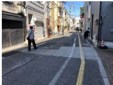
中央排水とした 歩道のない道路
