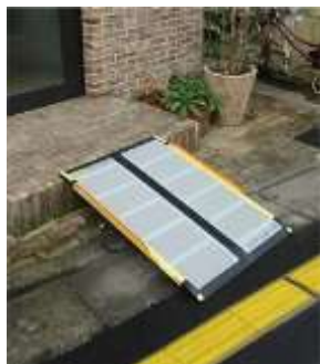
一時的に使用するための 段差解消スロープの設置例
