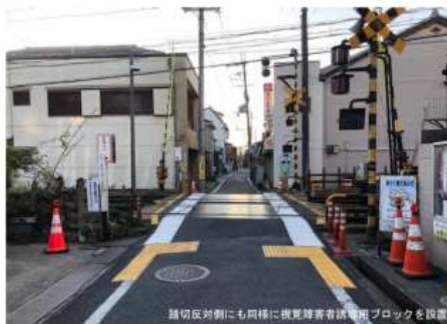
写真 2-7-8 踏切道手前部に視覚障害者誘導用ブロックを設置した事例
