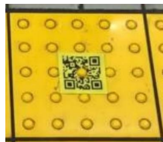
QR コードを設置した 点字ブロック
