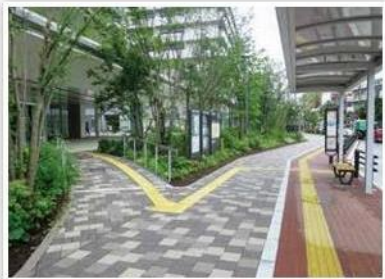
▲「うめとびあ」バス停から歩道を通りゆるやかな勾配のスロープでつながる通路です。連続して誘導用ブロックが敷設されました。
