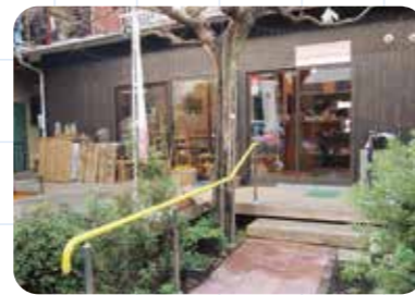
設置された黄色い手すり
