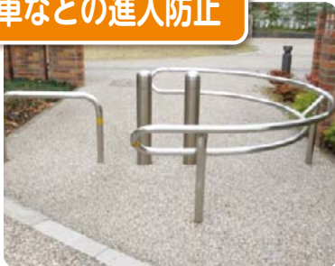
二輪車進入防止柵 (二段すり付き) のある公園
