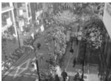
駅前商店街の通りの 改修後の様子
