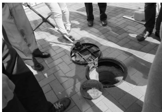
区立施設内のマンホールトイレ整備事例
