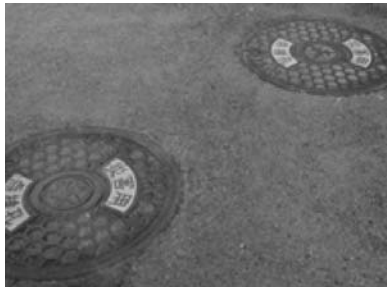
マンホールトイレ
