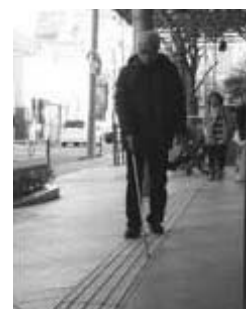
誘導用ブロックの 敷設確認の様子
