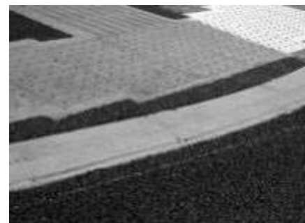
整備された歩車道境界部
