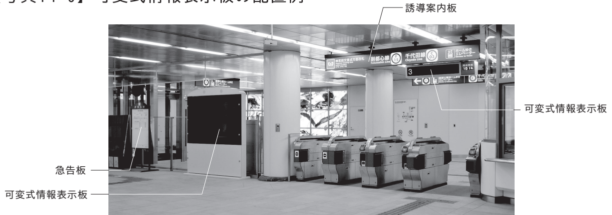
【写真14-6】 可変式情報表示板の配置例
