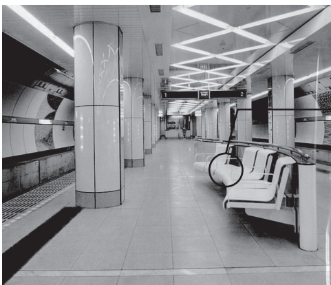
【写真12-2】 ベンチとベンチの間に荷物置きを設置した例
