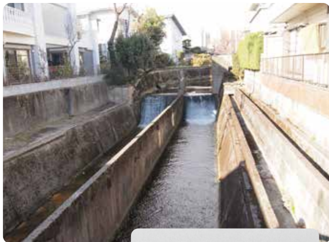
姫之橋から上流を見る
