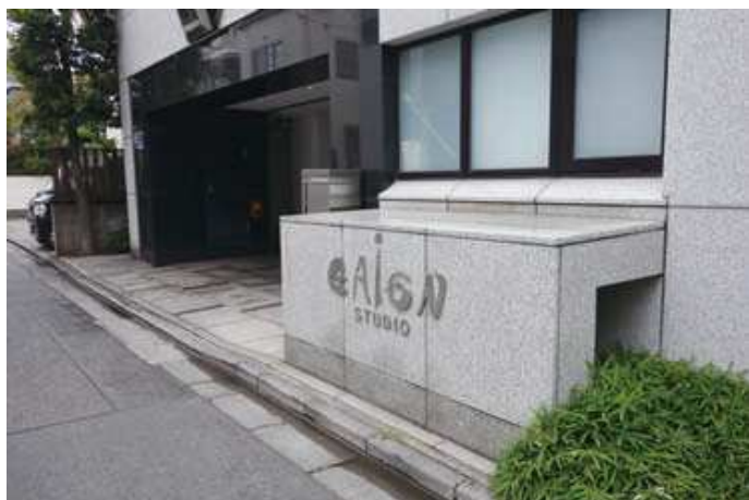
建築物と一体的な素材でデザインされた屋外広告物
