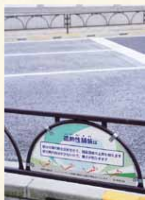
遮熱性舗装(補助第154号線)
