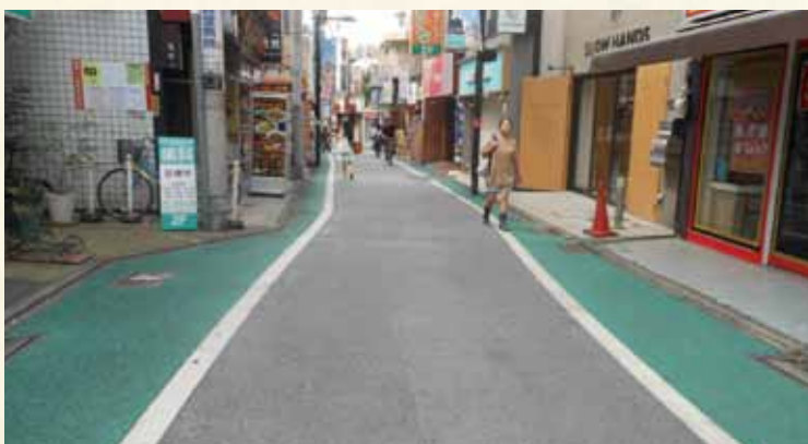
遮熱性舗装(農大通り)
