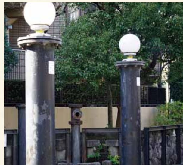
水道管を使った街路灯と壁泉(弦巻プロムナード周辺)
