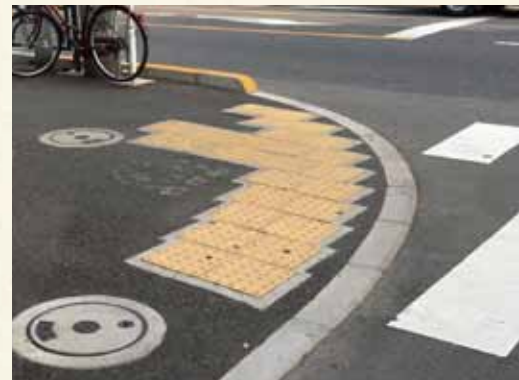
適切に整備された誘導ブロック
