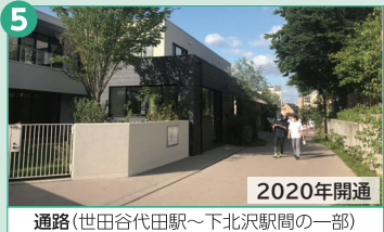
2020年開通 通路(世田谷代田駅~下北沢駅間の一部) 通路と建築敷地が一体的な空間に感じられるように仕上げを工夫しました。
