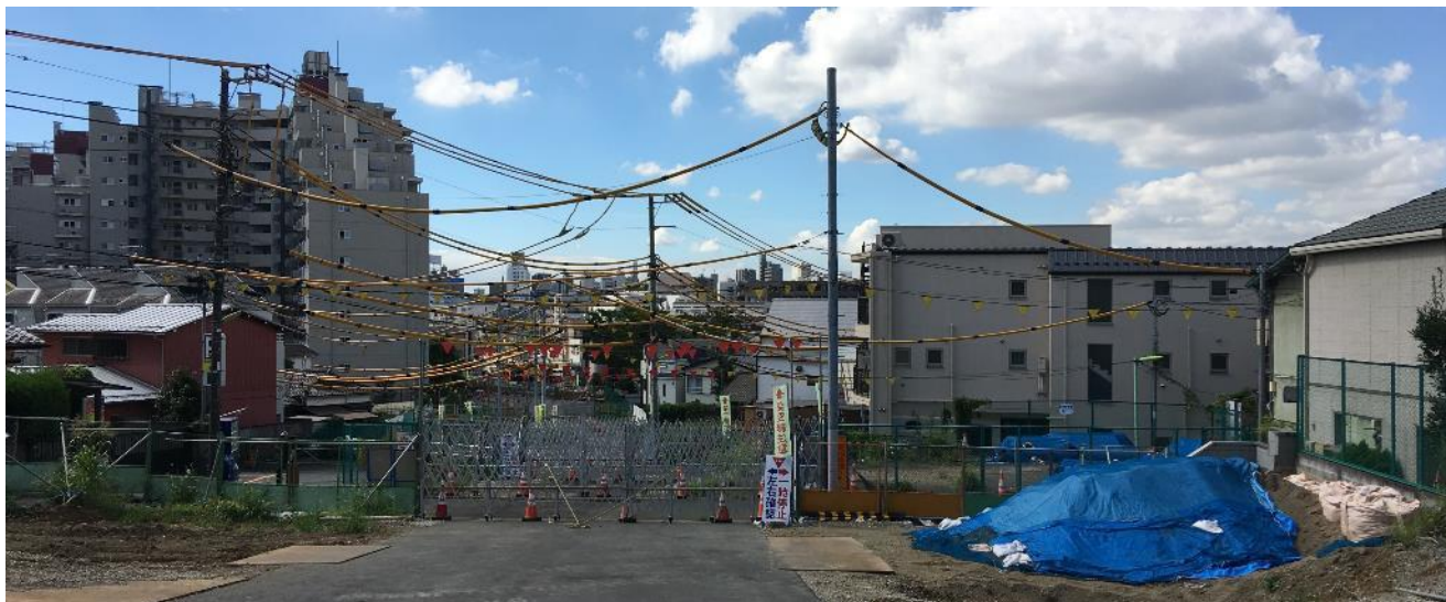
工事中の 現地の様子→
