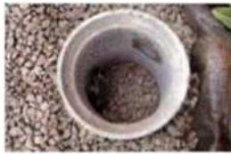
雨水浸透ます
