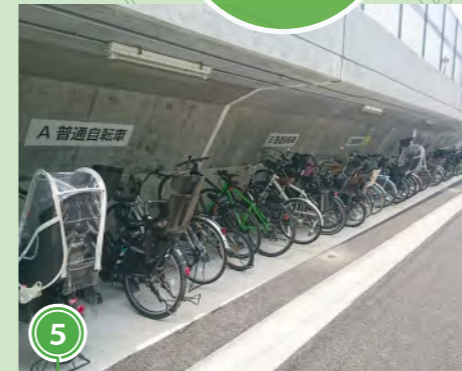
5 自転車等駐車場 下北沢駅周辺の駐輪場不足を解消するため茶沢通り東側の通路下に98台の駐輪場を整備しました。
