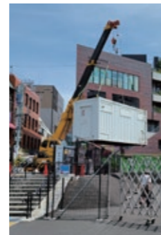
移設工事の様子(クレーンで吊り上げました。)
