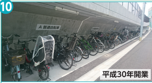
下北沢東自転車等駐車場
