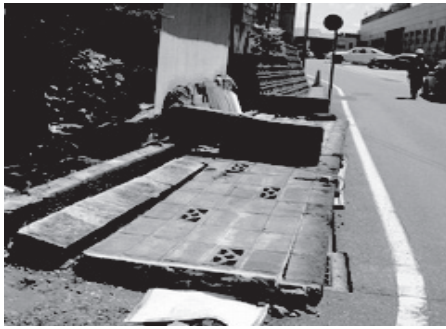
ブロック塀等の倒壊被害の例
