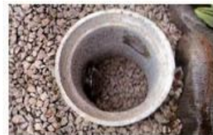
雨水浸透ます
