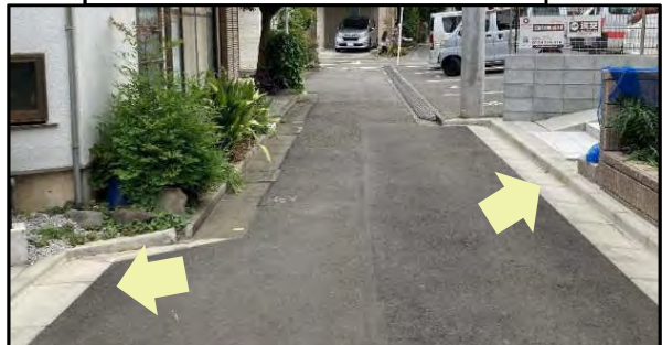
拡幅部分を車道状に整備
