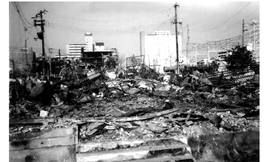
◇火災の延焼による被害 (平成7年1月阪神淡路大震災)
