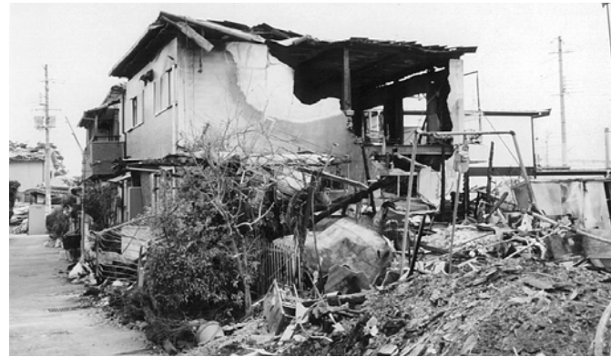
◇周辺への延焼を止めた鉄骨2階建ての戸建住宅 (平成7年1月阪神淡路大震災)
