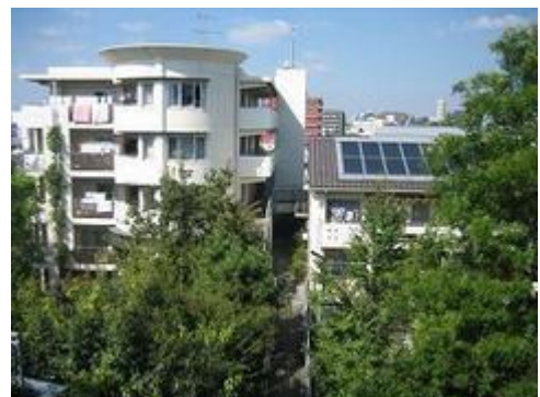
（世田谷区深沢環境共生住宅）
