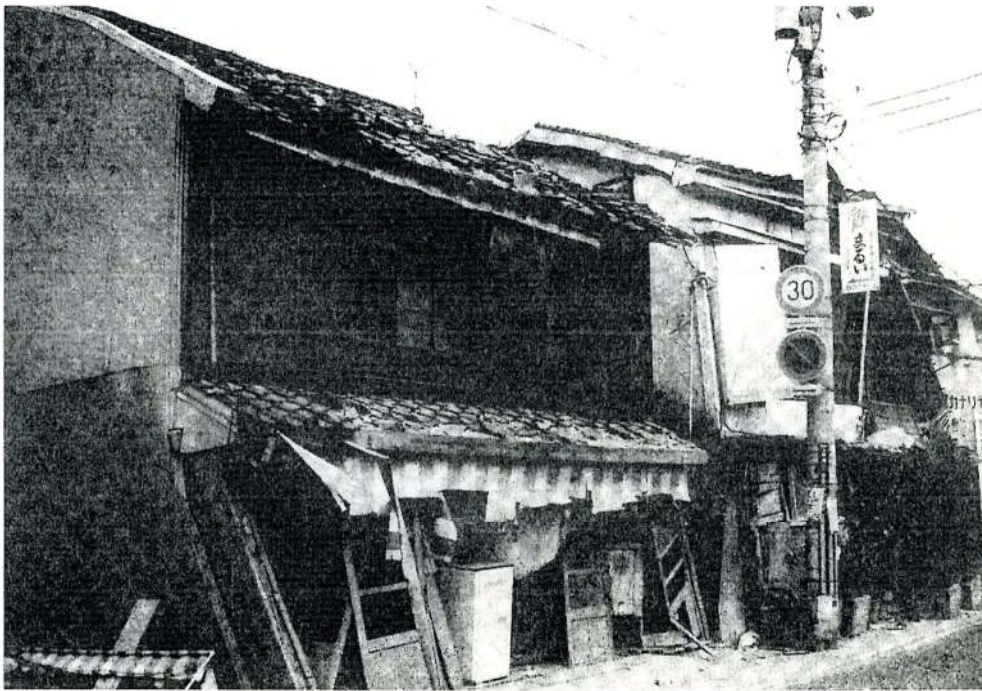
阪神大震災で被害を受けた家屋
