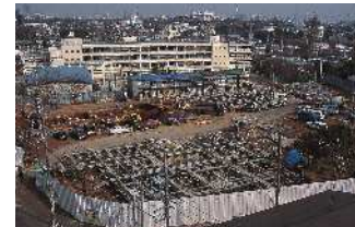
いよいよ始まった建て替え工事
