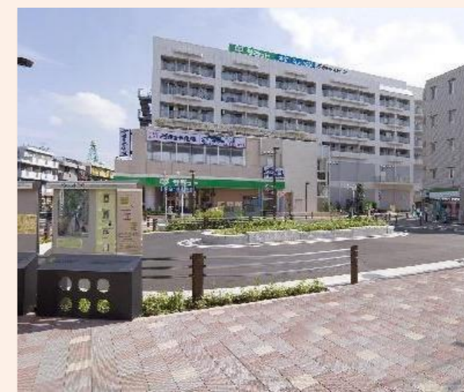
駅前交通広場(整備後)
