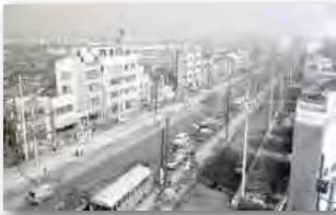
池尻町道路拡幅 (昭和38年)
