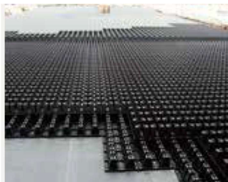
左：地下浸透貯留施設（出典：積水化学工業株式会社 HP） 右：レインガーデン（出典：竹中工務店 HP）
