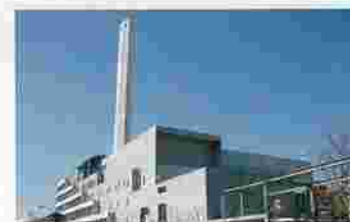
熱源を供給する千歳清掃工場
