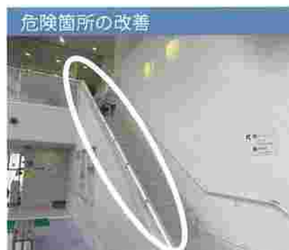
危険箇所に手すりの取り付け
