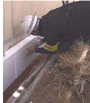
外壁の断熱化工事
