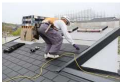
屋根の断熱化工事
