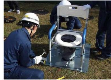
トイレ設置の様子（例）
