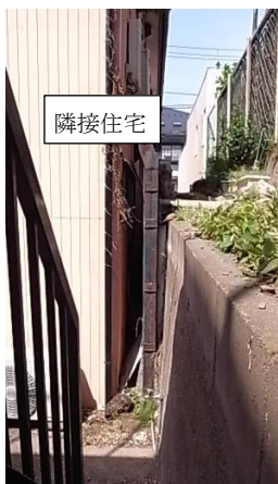
現況写真②：南側隣地境界擁壁
