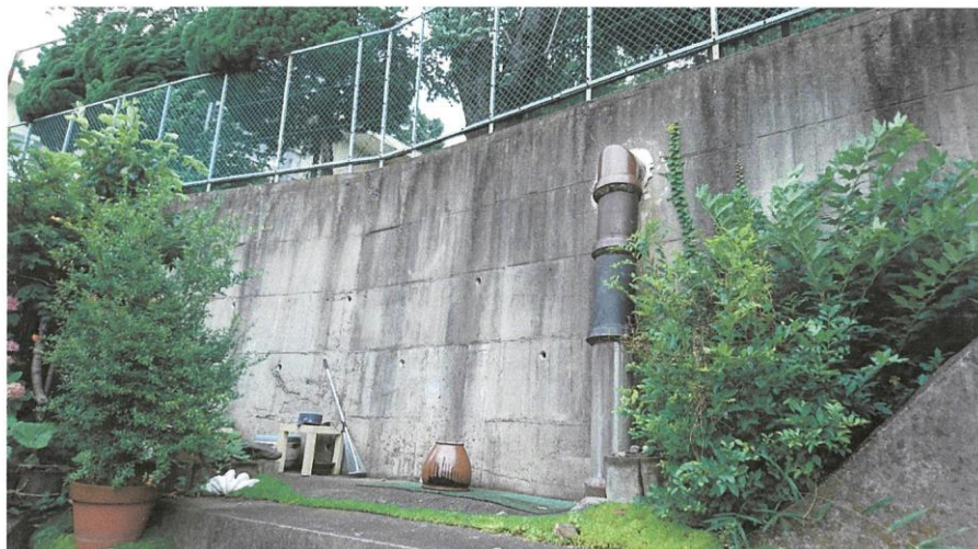
現況写真③：南側隣地境界擁壁
